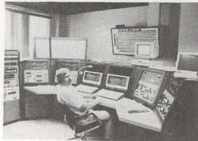
La salle de contrôle
