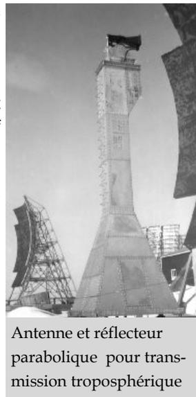
Antenne et réflecteur parabolique pour transmission troposphérique
