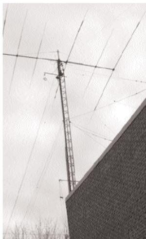
Son antenne HF TH-6. On peut voir sur le coin du toit un gammamatch qui permet d'utiliser la tour comme antenne de 160 mètres
